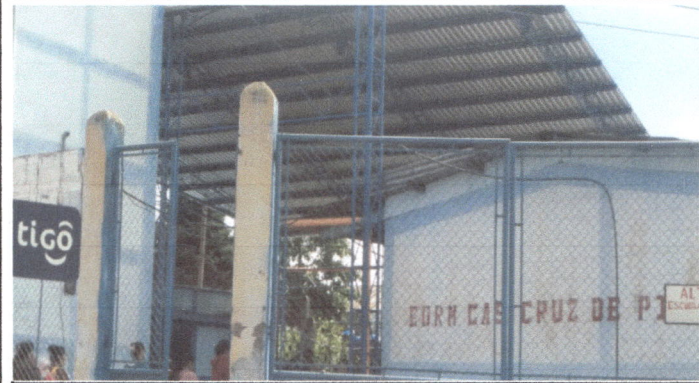
Foto 1: Cubierta de lámina
