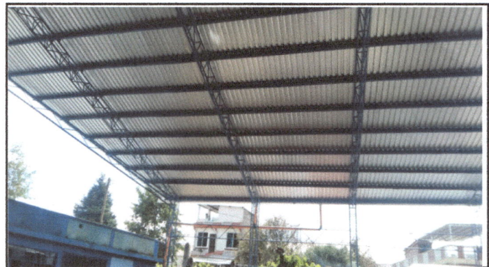
Foto 2: Cubierta de lámina
