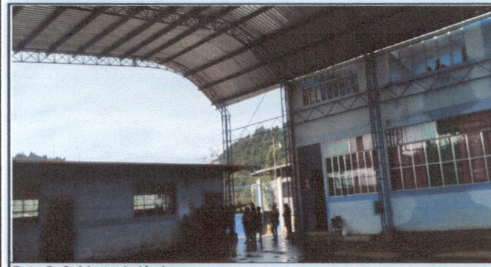
Foto 5: Cubierta de lámina
