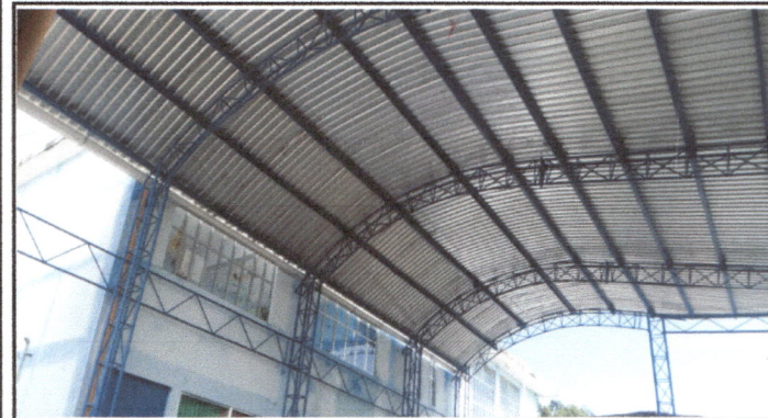
Foto 3: Cubierta de lámina
